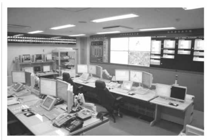
高機能消防指令システム
